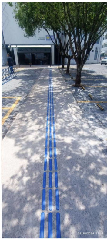
Figura 2: Piso podotátil acesso.
