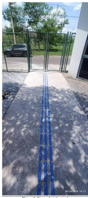
Figura 1: Piso podotátil entrada.
